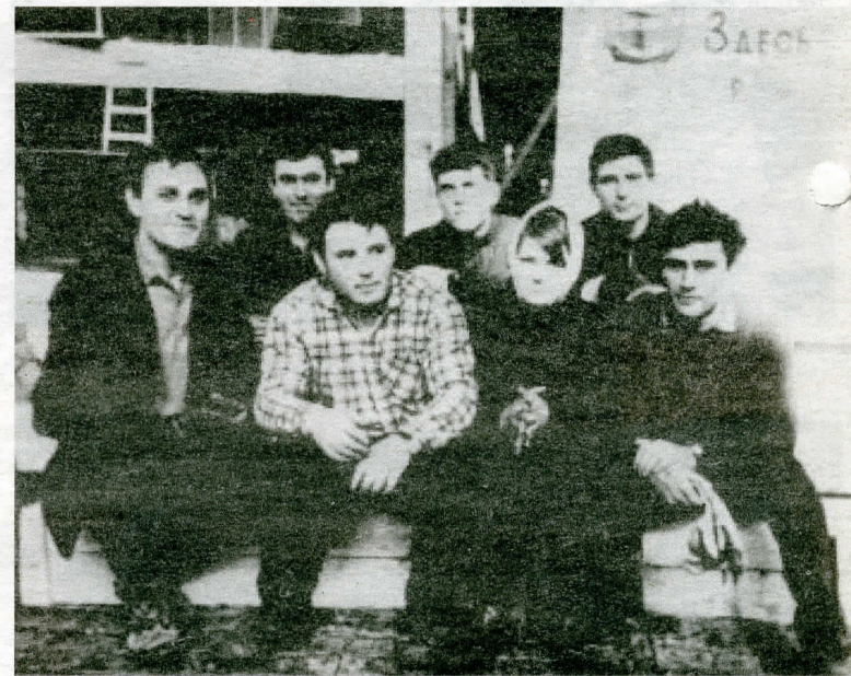
Представители заводского комитета ВЛКСМ — на возведении фундамента ФО-2 в строящемся главном корпусе ВАЗа, 1969 год.
