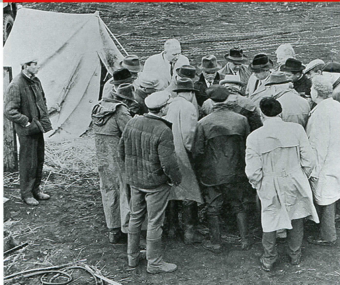
В.Н. Поляков на первой стройплощадке.
