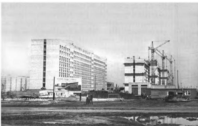
Начало строительства кинотеатра «Сатурн»
