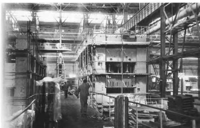
Монтаж оборудования в прессовом производстве
