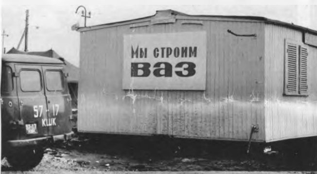
Контора строителей-комсомольцев студенческих отрядов
