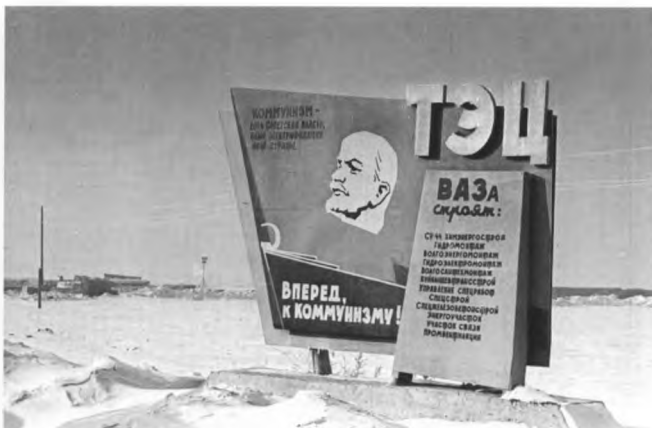
Первый объект строительства автозавода – ТЭЦ
