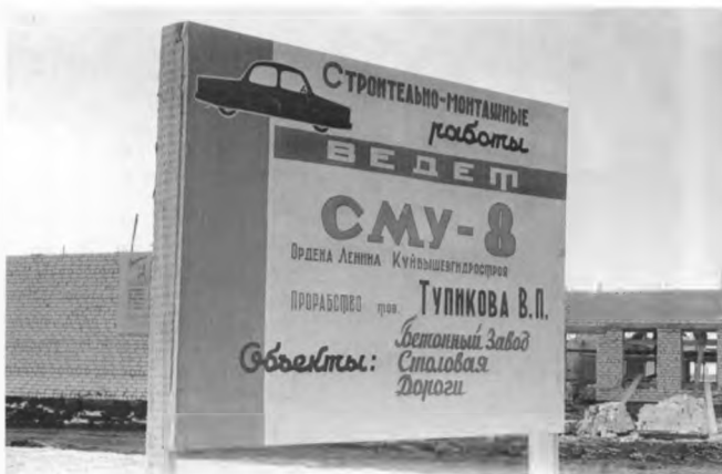
Производственную базу строительства возводили работники СМУ-8
