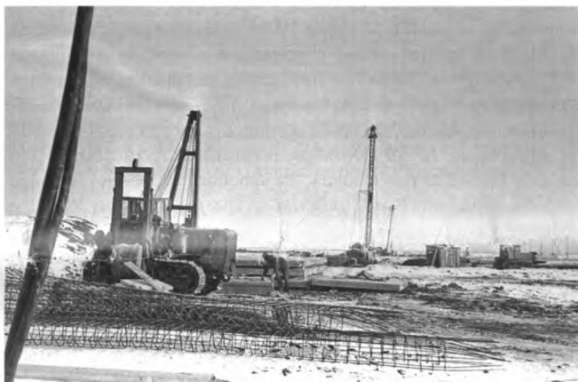
Начало создания производственной базы строительства ВАЗа. Зима 1966/67 г.
