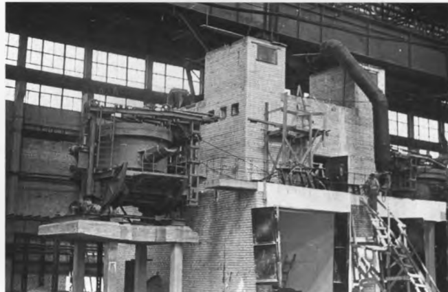
Монтаж оборудования в металлургическом производстве
