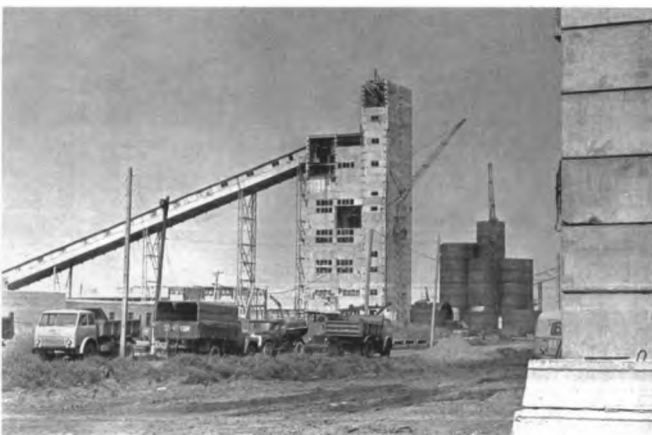
Большой бетонный завод
