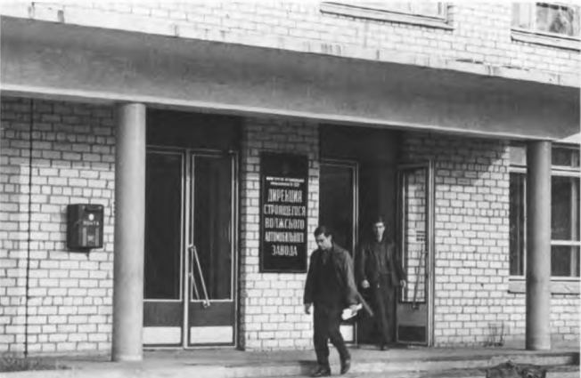
Здание дирекции строящегося Волжского автозавода
