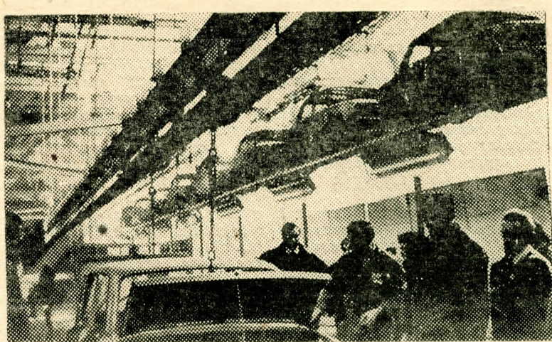
ИДЕТ МОНТАЖ ПОДВЕСОК КОНВЕЙЕРА.
