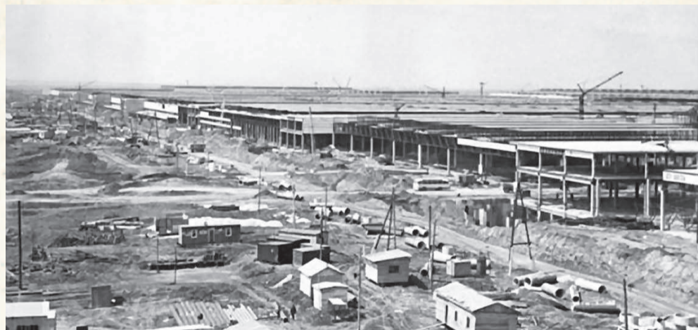
Июль 1969 года, главный корпус. Архивное фото передаёт масштаб события: строители ВАЗа возвели гигантские корпуса, смонтировали сложнейшее оборудование и запустили производство народного автомобиля
