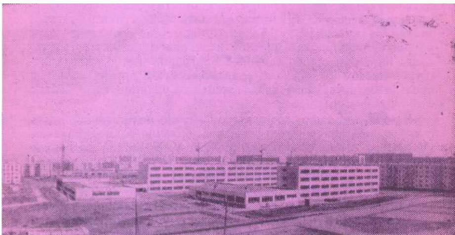
Рис. 15. Экспериментальная каркасно-панельная школа на 2352 учащихся в жилом районе № 1. Фото 1969 г.
