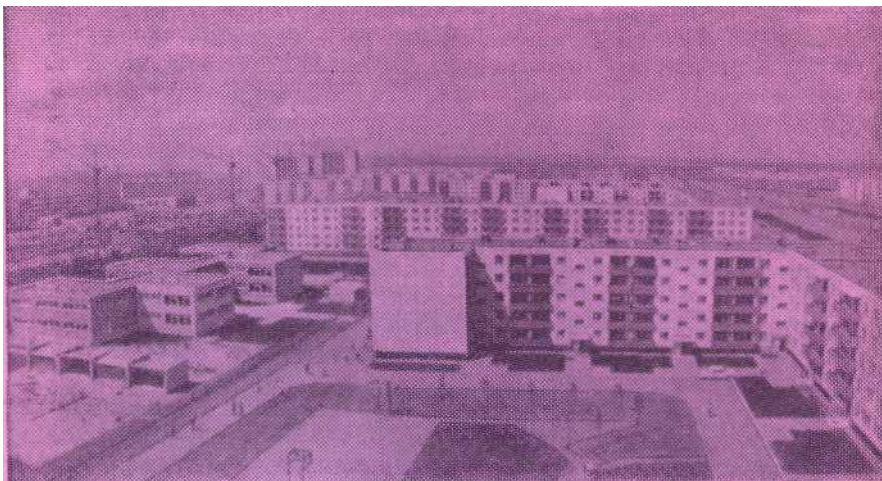
Рис. 14. Детский сад-ясли на 280 мест (слева) в жилом районе № 2.
